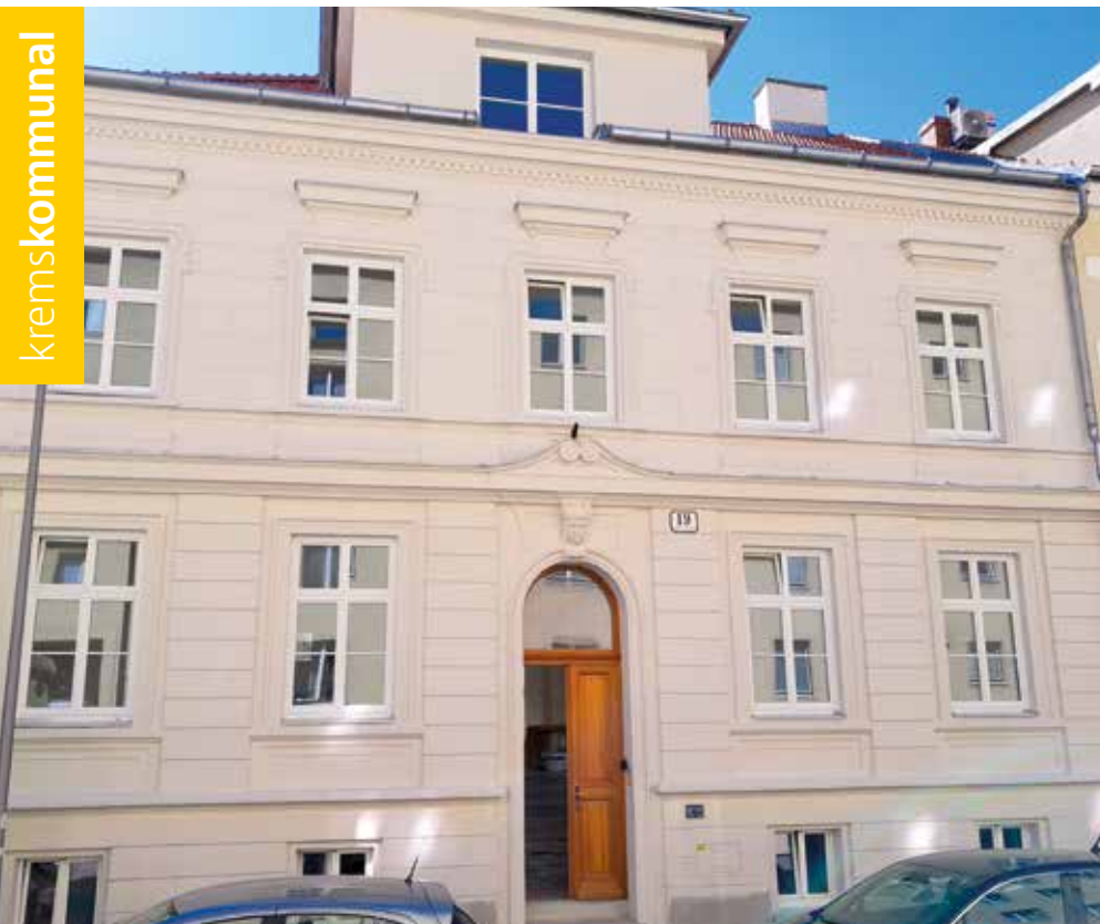
Beispielhafte Fassaden- sanierung in der Kaserstraße
